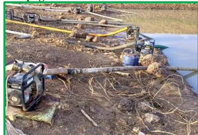
Pompage dans le lac
