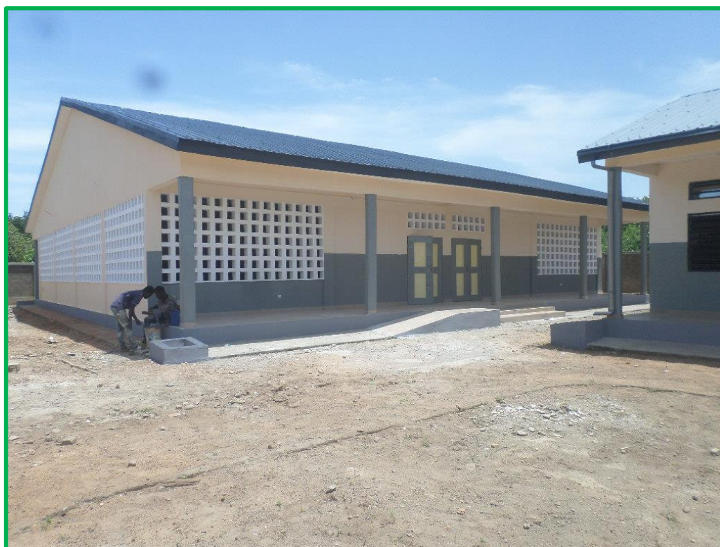
Vue d'ensemble sur le nouveau bâtiment de 377 m 2
