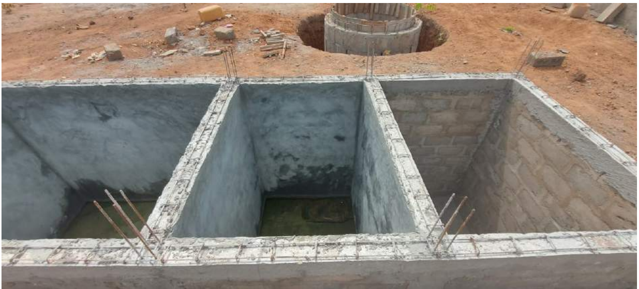
fosses septique niveau enduit étanche et puisard
