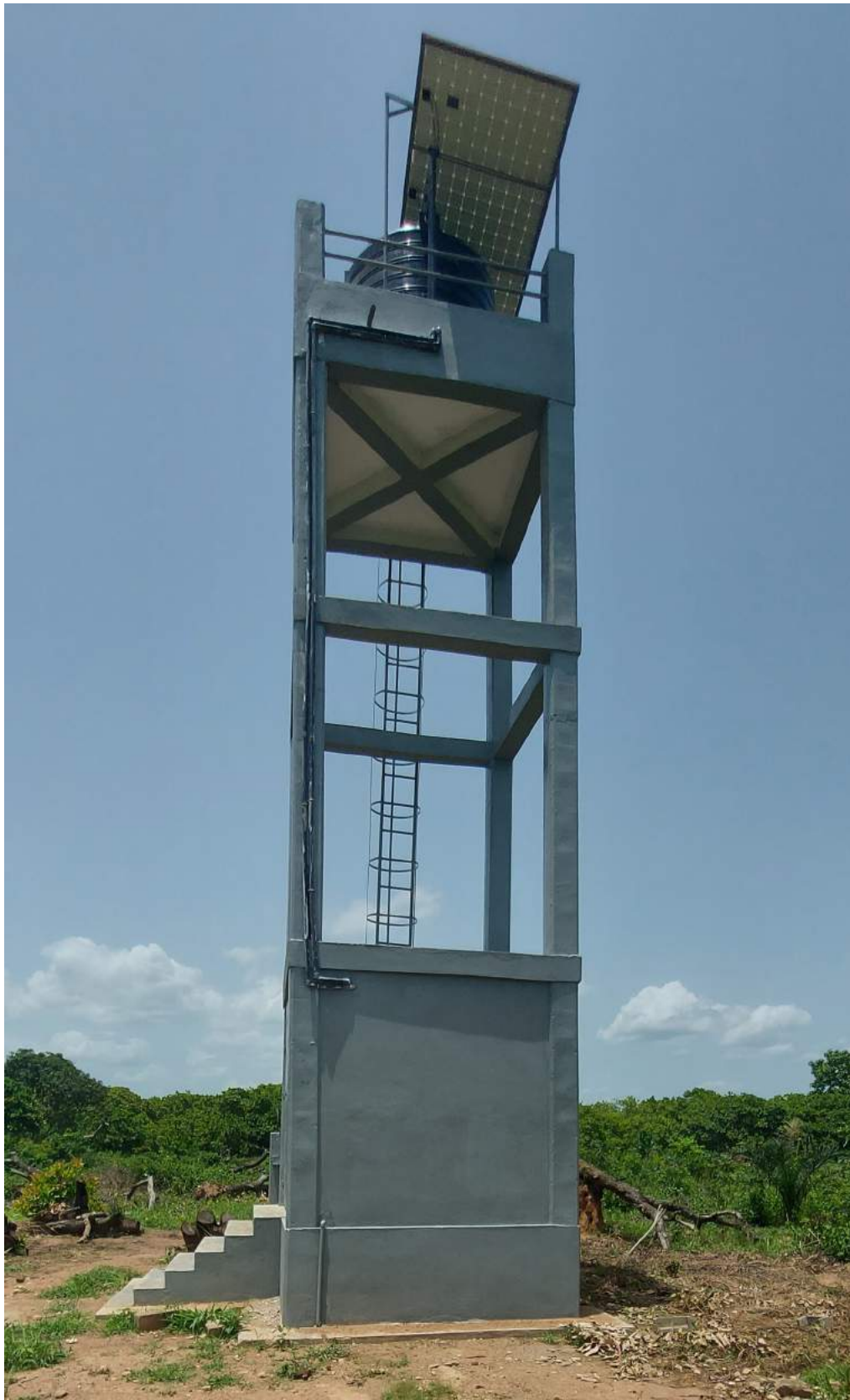
Photo 16 : Superstructure de l'AEP avec polytank et panneaux solaires
