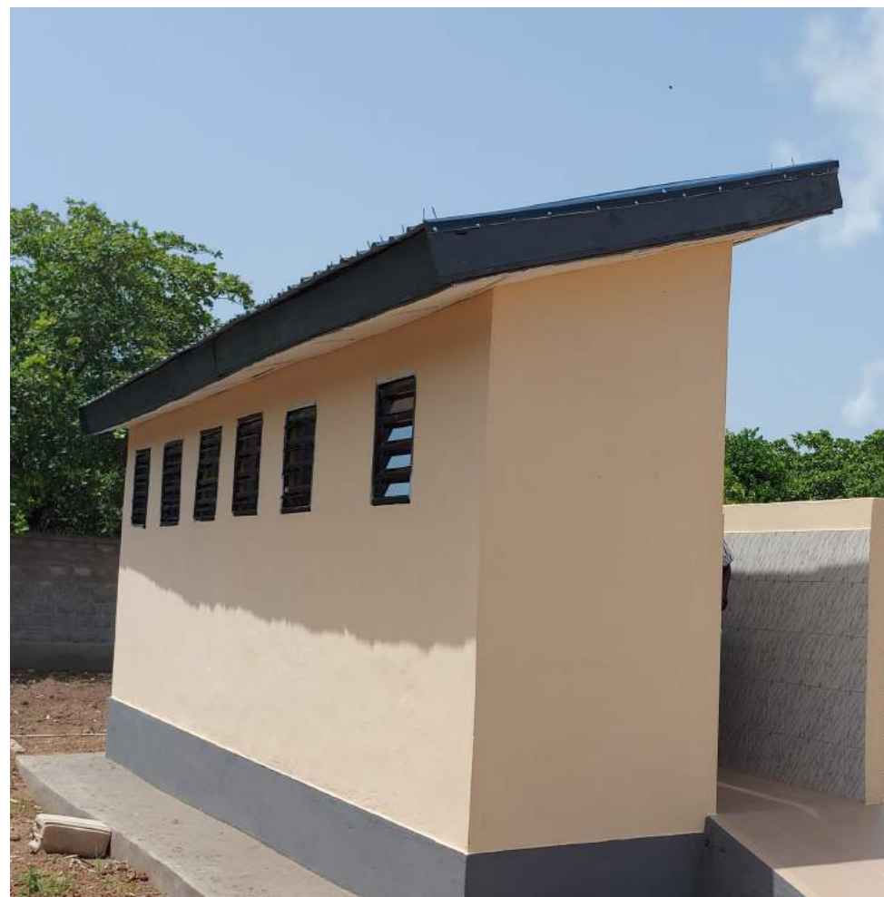
Photo 12 : Bloc de latrines
