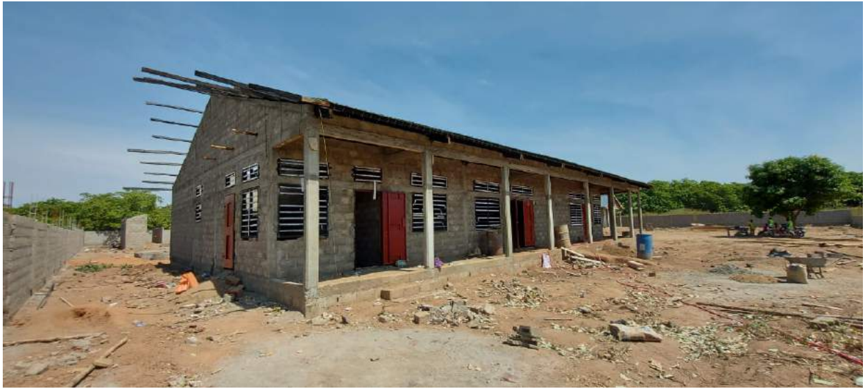
Bâtiment principal : niveau charpente-toitures pose de portes et fenêtres
