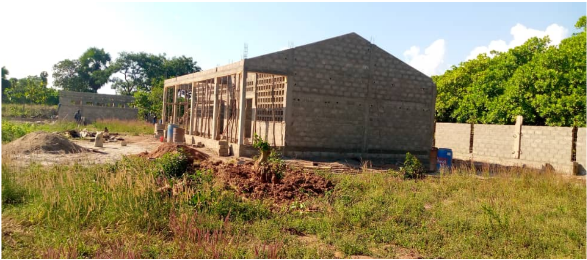
Bâtiment de mécanique et de menuiserie au niveau pignons
