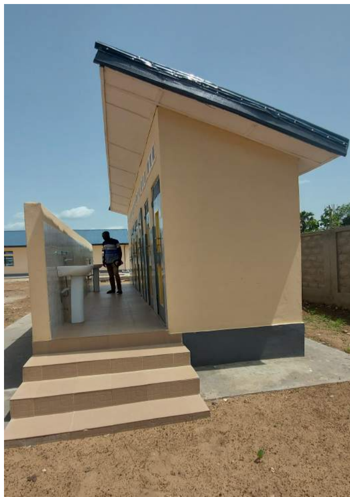
Photo 11 : Bloc de latrines
