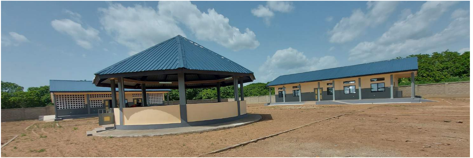
Photo 2 : Vue d'ensemble paillette- atelier de menuiserie & mécanique- atelier couture &artisanat
