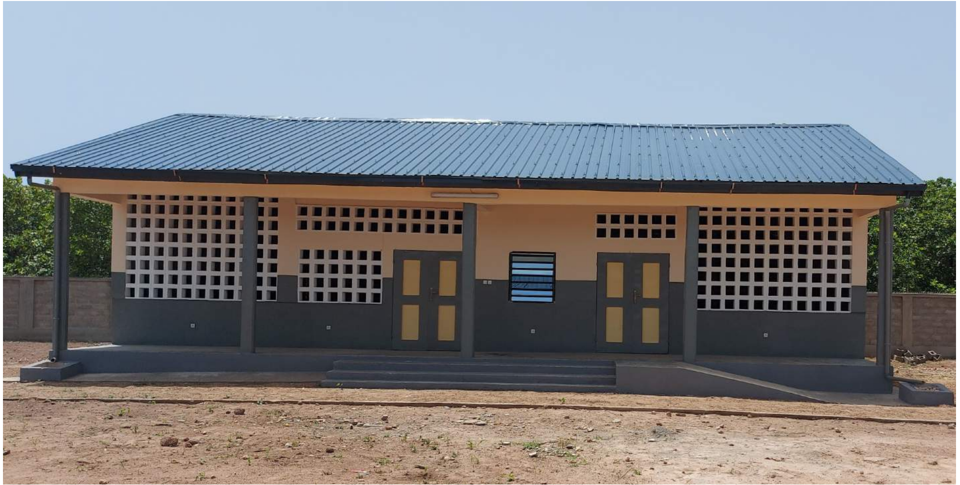
Photo 7 : Bâtiment de mécanique et de menuiserie
