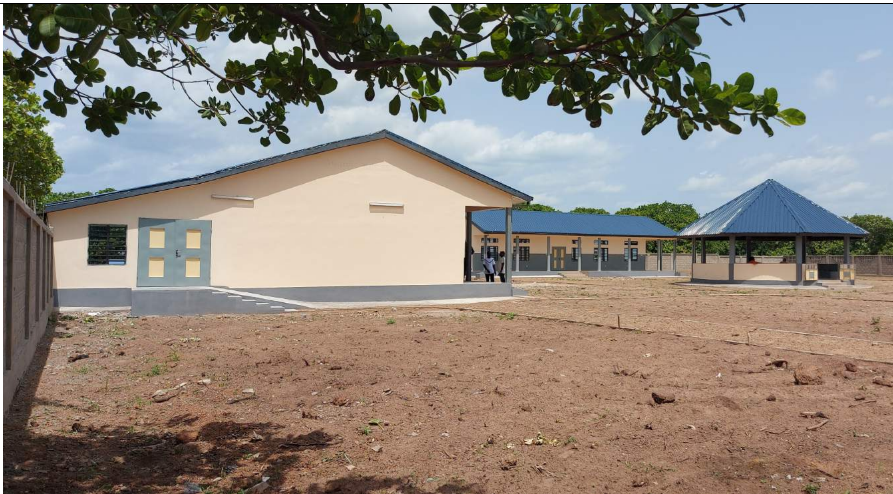
Photo 3 : Vue d'ensemble paillette- atelier de menuiserie & mécanique- atelier couture & artisanat
