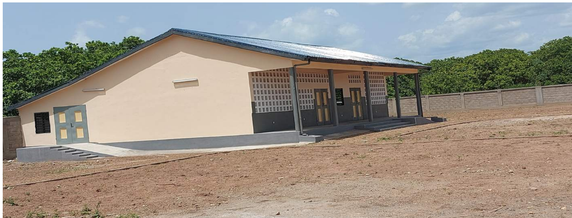
Photo 6 : Bâtiment de mécanique et de menuiserie
