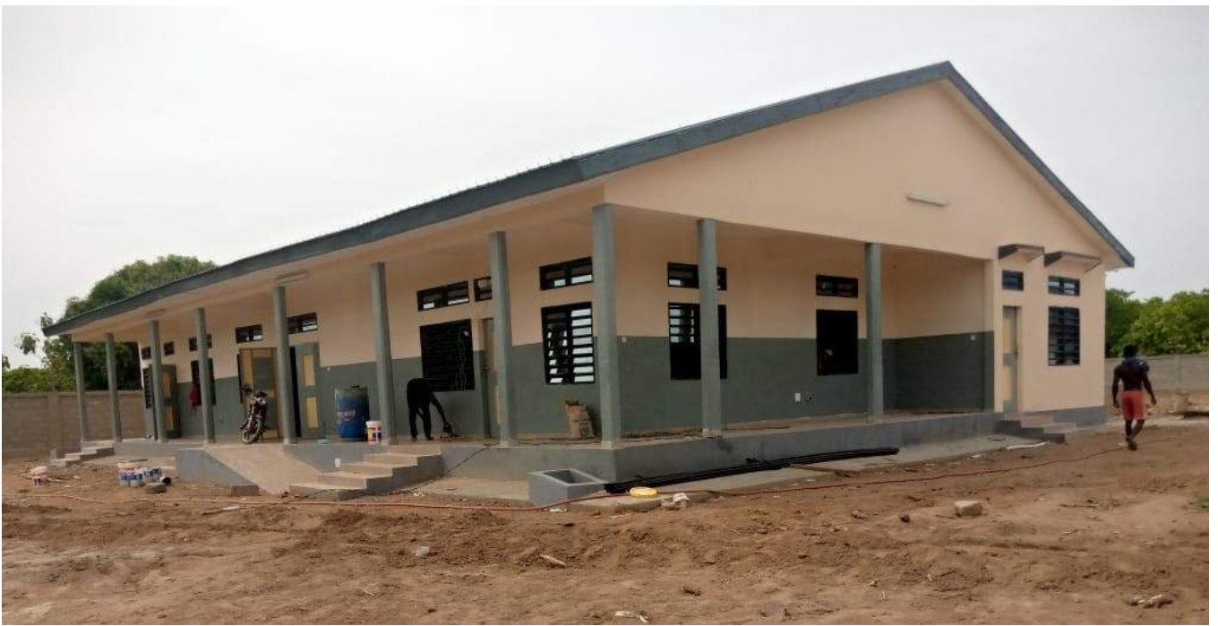
Bâtiment principal : Finitions diverses
