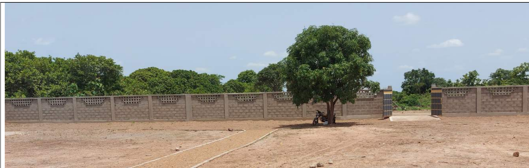
Photo 13 : Clôture et portail coté façade principale
