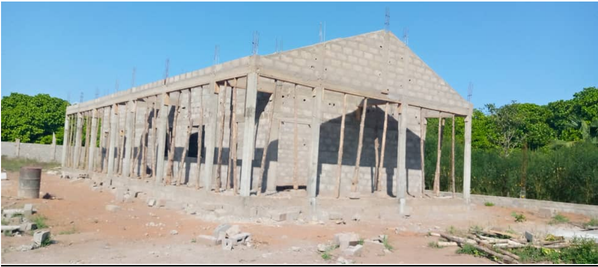
Bâtiment de couture et artisanat au niveau pignons
