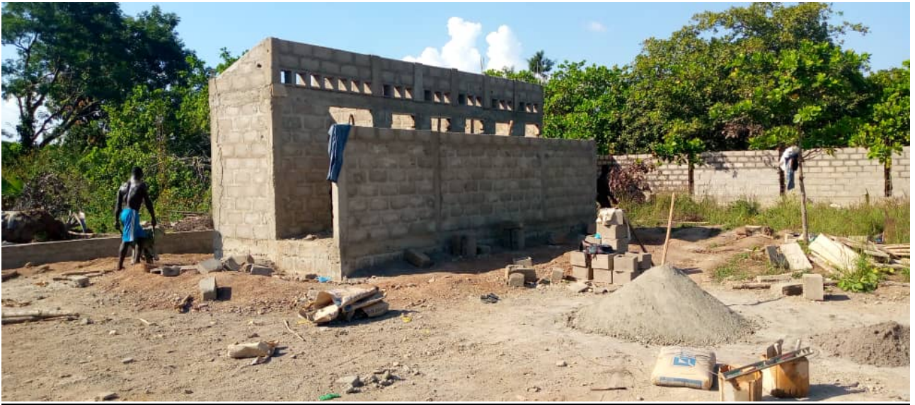
Bloc de latrines au niveau pignons
