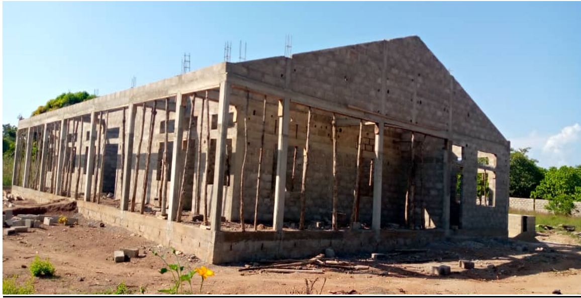
Bâtiment principal au niveau pignons
