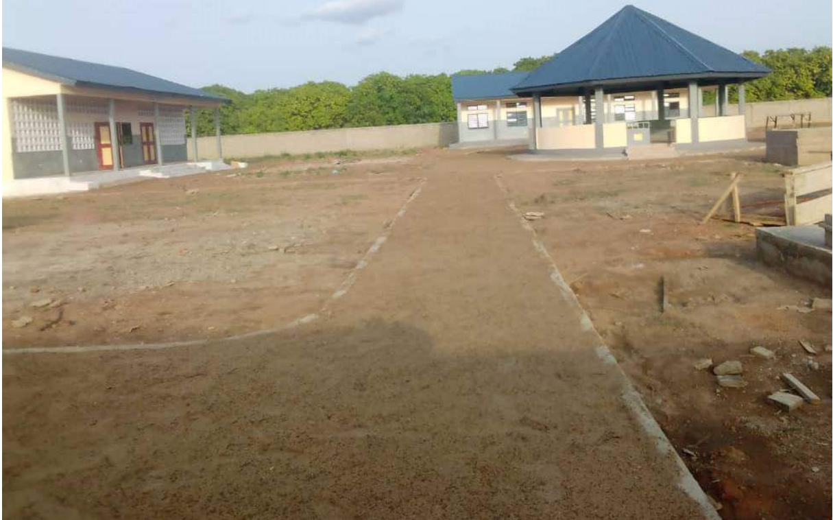
Aménagement des allées reliant les différents ouvrages
