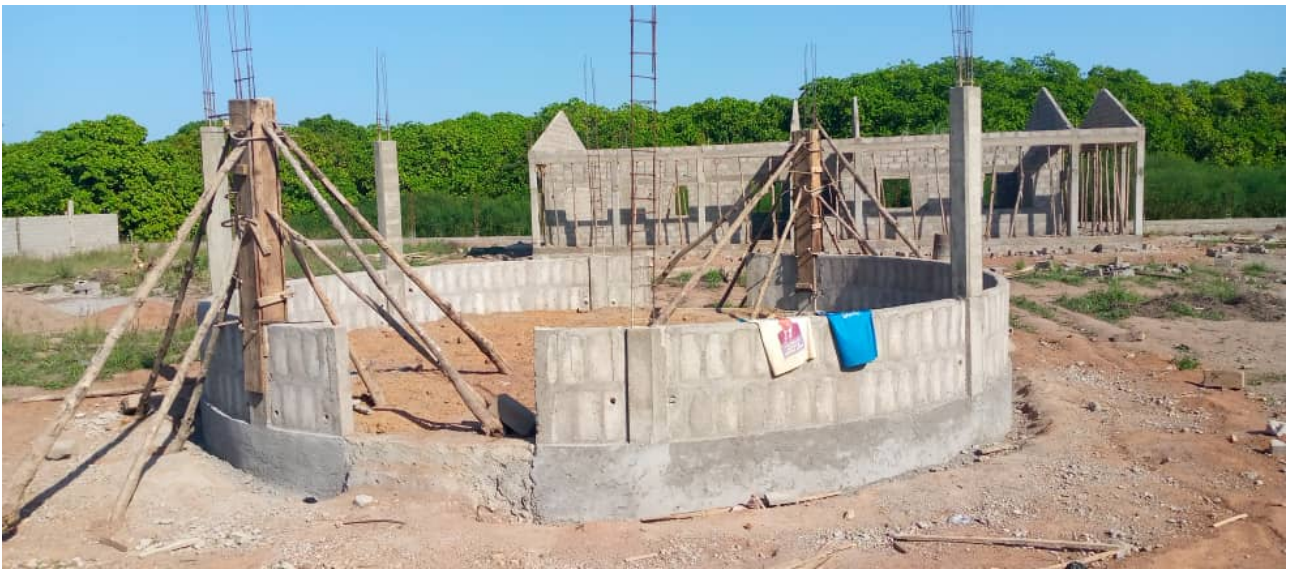
Hangar circulaire au niveau élévations
