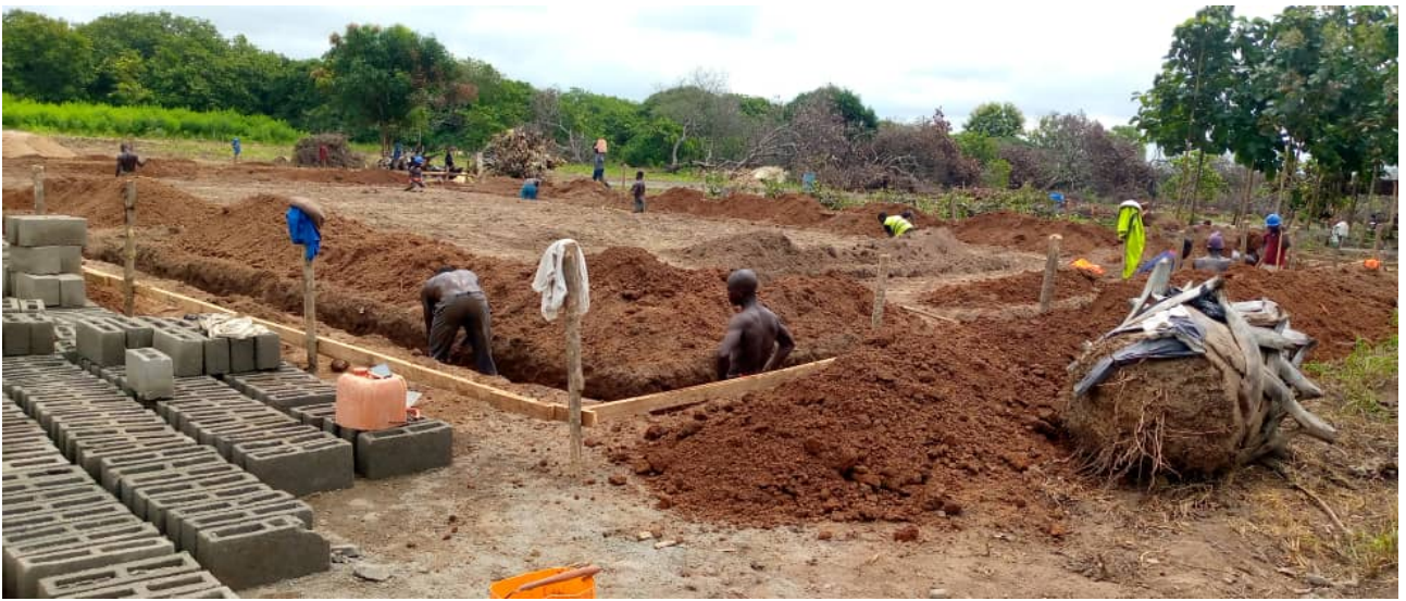
Travaux de fouilles
