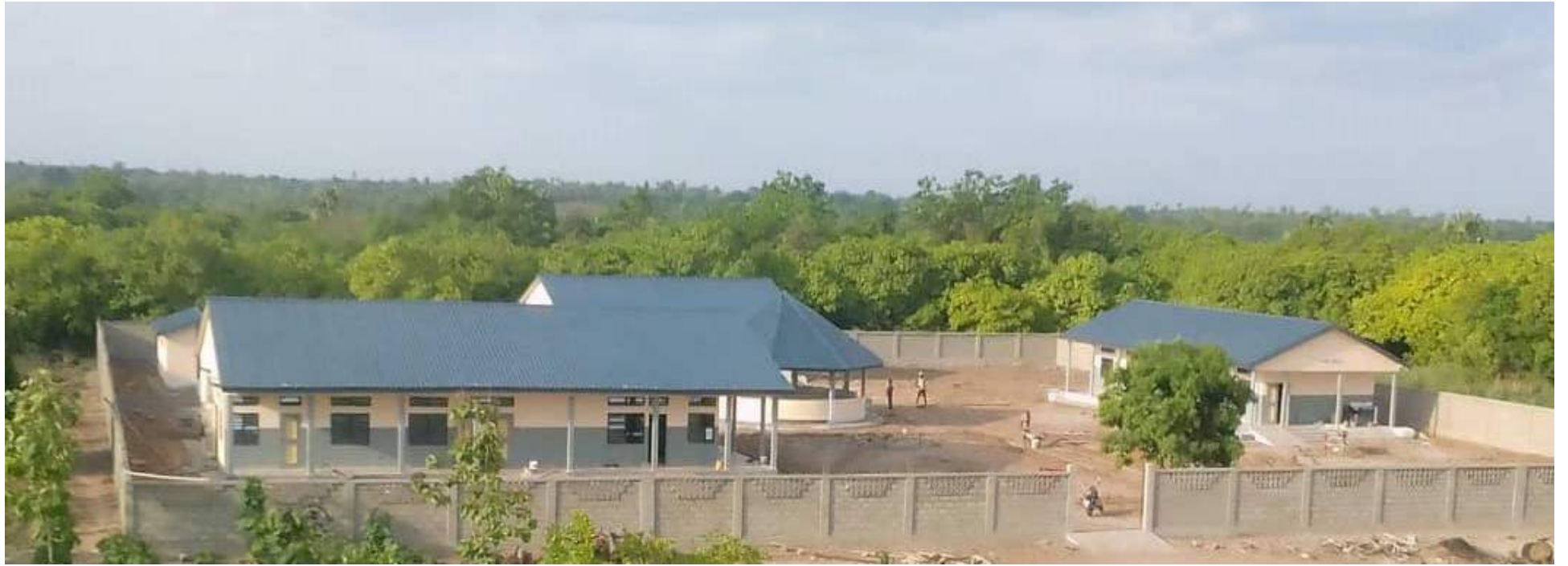
Photo 1 : Vue d'ensemble des ouvrages
