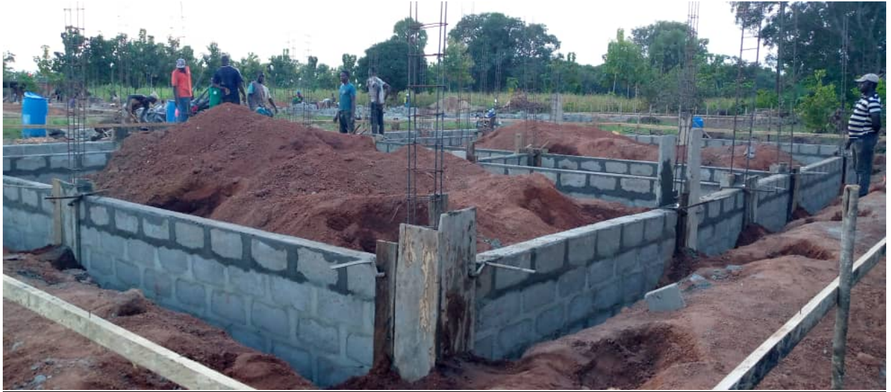
Travaux de fondations
