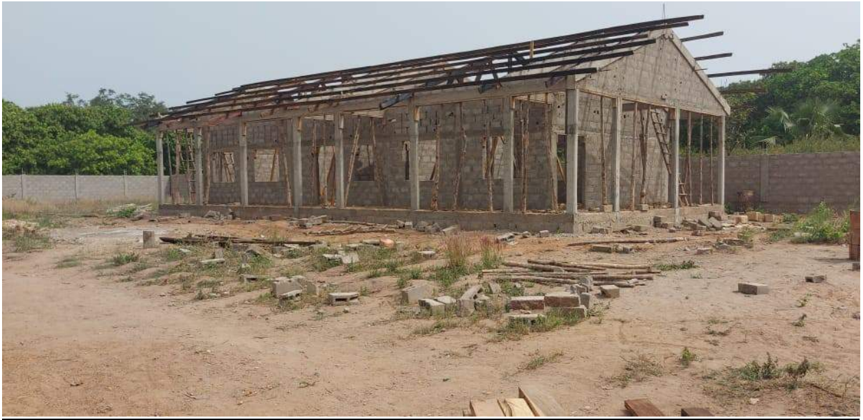
Bâtiment couture et artisanat : niveau charpente-toitures
