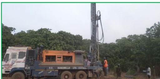
Le forage réalisé par l'OCDI
