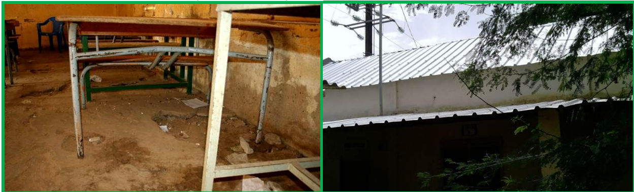
L'école Amadou Basse Sall avant les travaux
