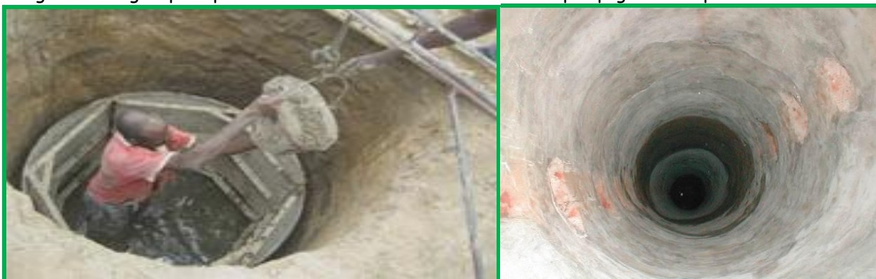
Construction de Puits dans la région de Lomé
