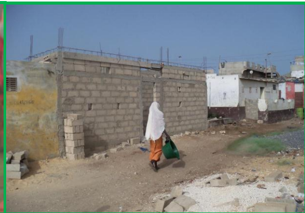
Construction de sanitaires à Siné
