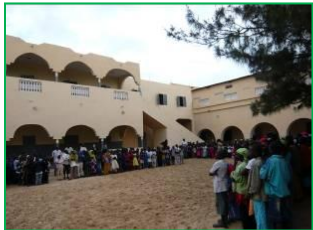
Le bâtiment scolaire ouest agrandi et surélevé
