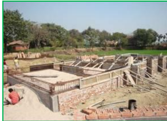
Les débuts de la construction du Centre
