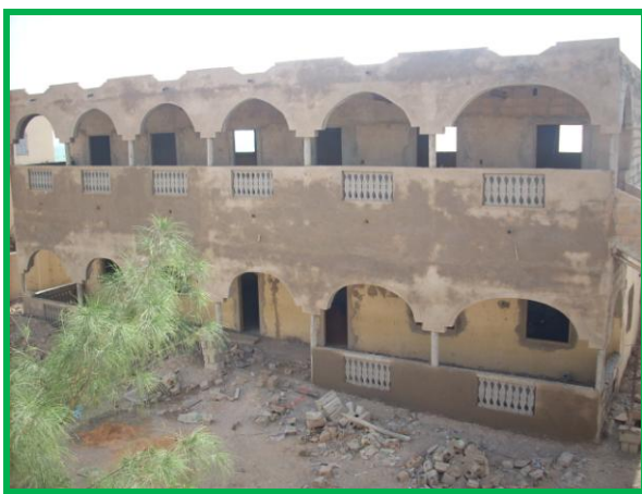
Surélévation du bâtiment
