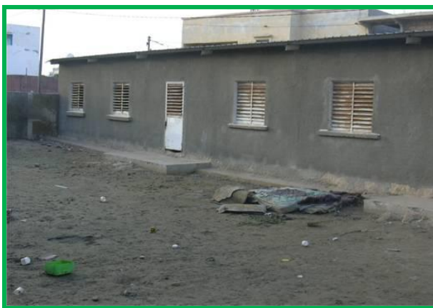
Bâtiments à réhabiliter pour l'école maternelle
