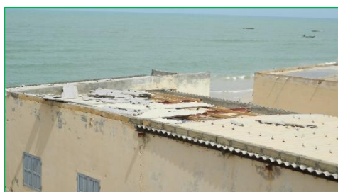
Toiture de la bibliothèque
