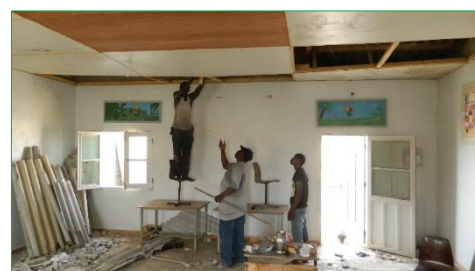
Réfection des plafonds
