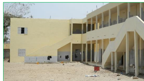
Ecole Dodds, les nouveaux bâtiments
