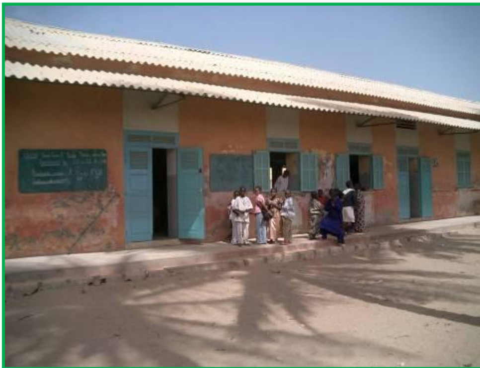
Le futur collège Samba Ndieme avant rénovation
