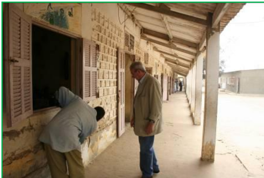
Ecole Dodds : Bâtiment Nord à réhabiliter
