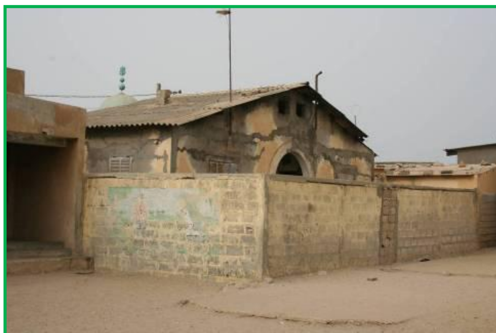
Ecole Dodds : Bâtiment à démolir
