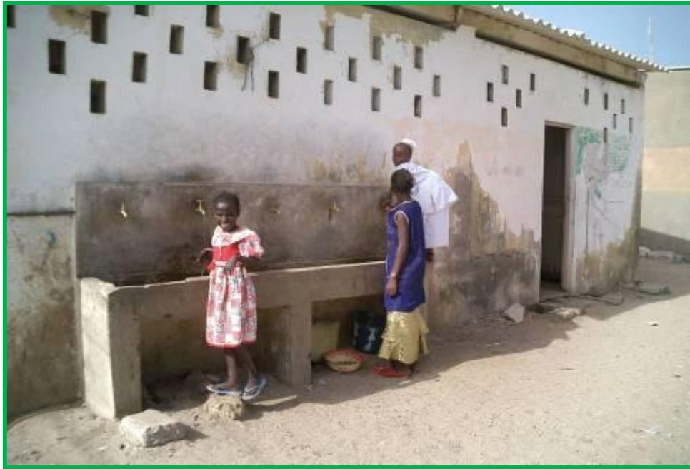
Etat actuel des installations sanitaires
