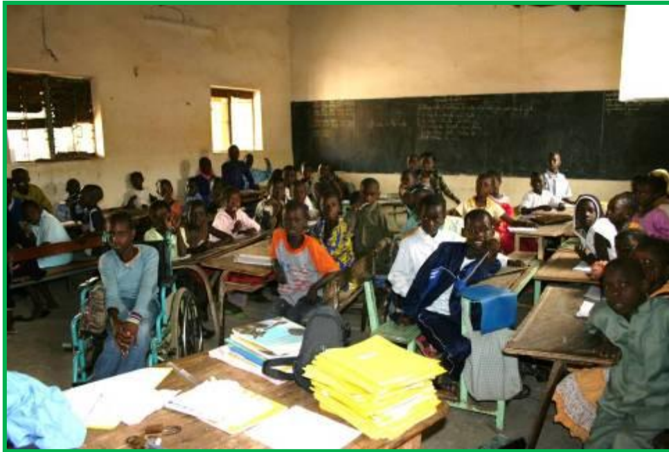
Etat actuel des salles de classes à réhabiliter
