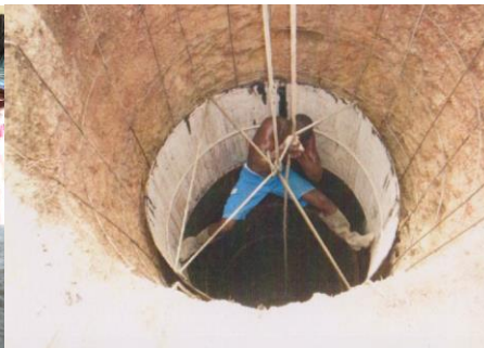
Creusement de puits au Togo
