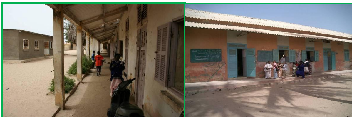
Ecole Dodds : Bâtiment Nord à rénover
